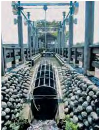
水の小径の螺旋水車
