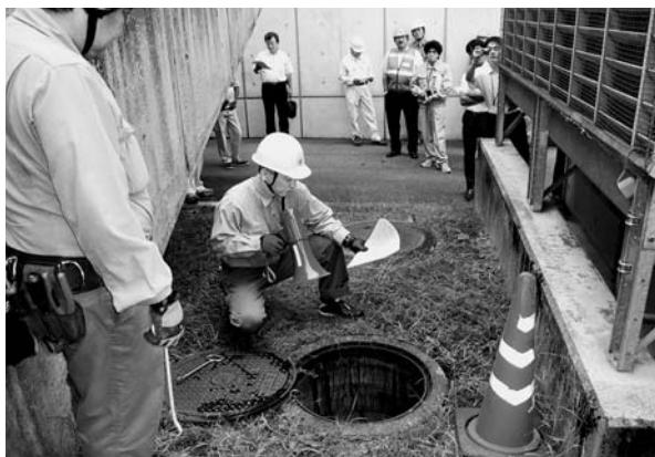
引込ケーブルが損傷し電源設備が不作動との想定であった。担当者が迅速に行動し、現場調査の結果、点検結果及び仮設ケーブルによる仮復旧及び発電機のリースが必要であることを、施設管理者に報告し、応急措置訓練は終了した。
