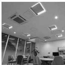
昭和電業株式会社 本社ビル (大阪府)
